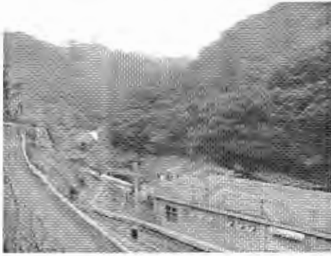
黒川第1発電所
