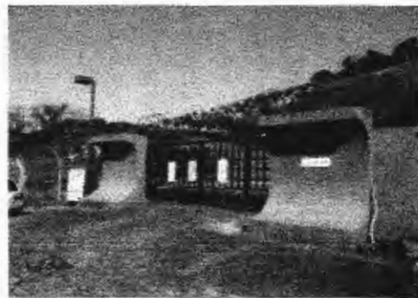
立田山配水池 (記念碑より上る)
